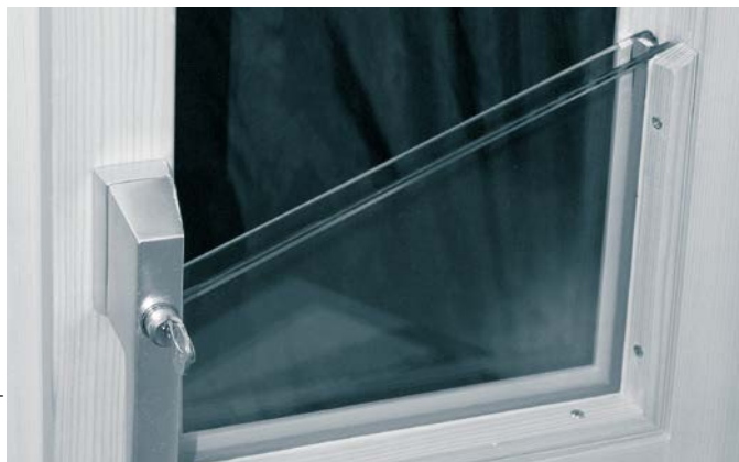
Illustrazione 13: vetro stratificato (VSG) P4A per RC 2 secondo la norma EN 356 (vetri speciali).
